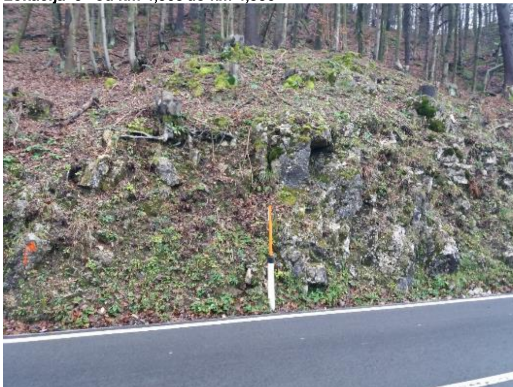
Lokacija 5 od km 4,503 do km 4,530
