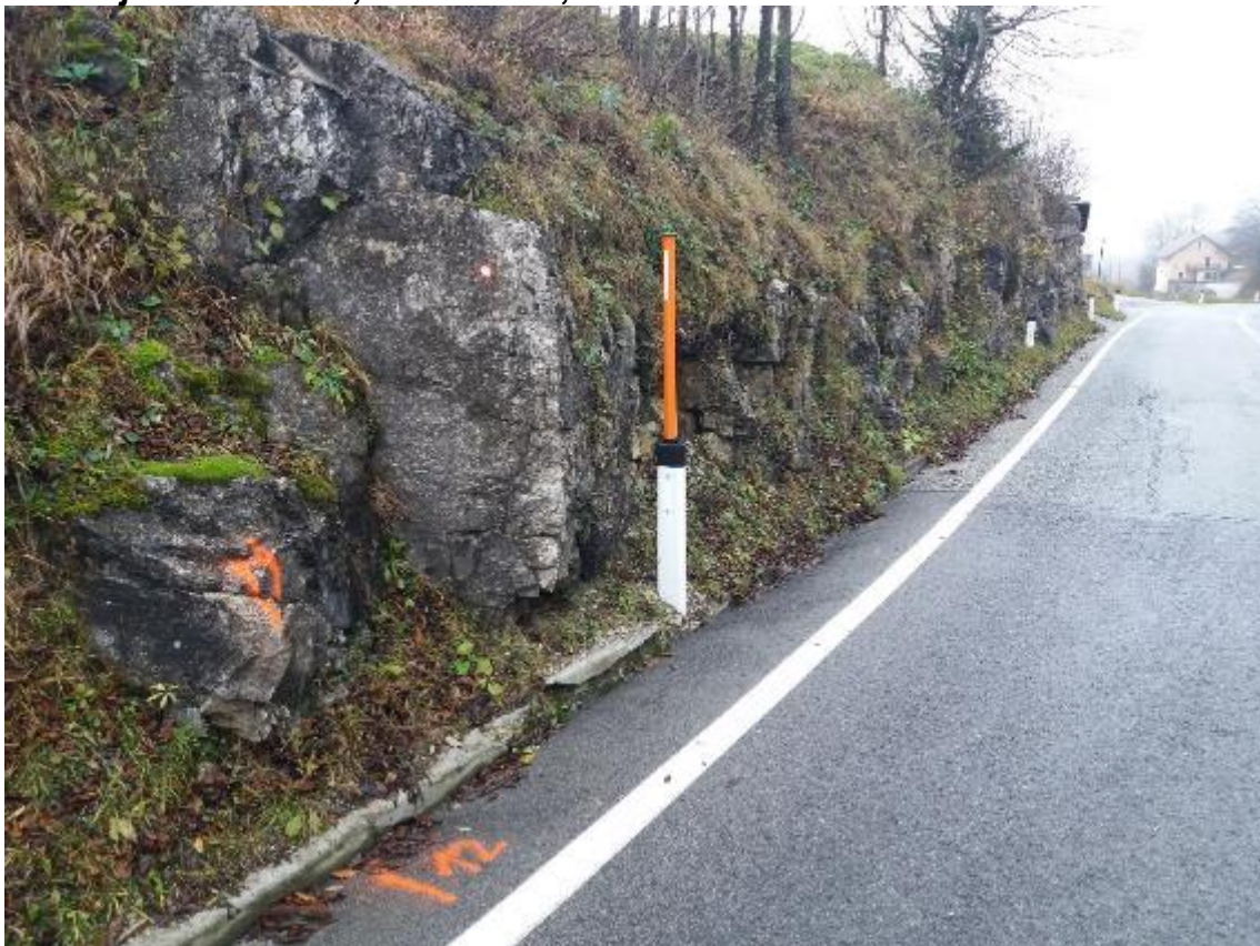
Lokacija 12 od km 5,485 do km 5,513
