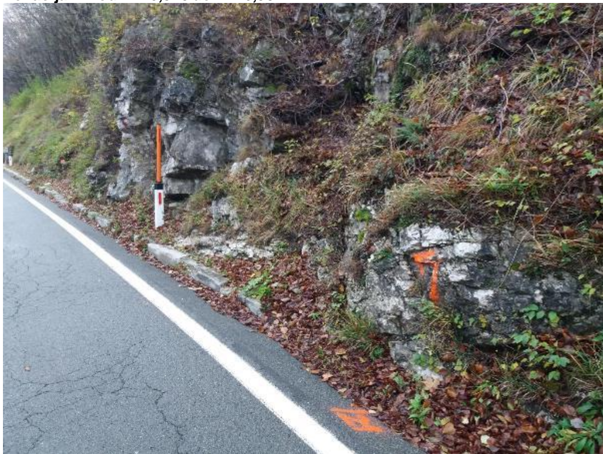
Lokacija 21 od km 6,970 do km 6,984
