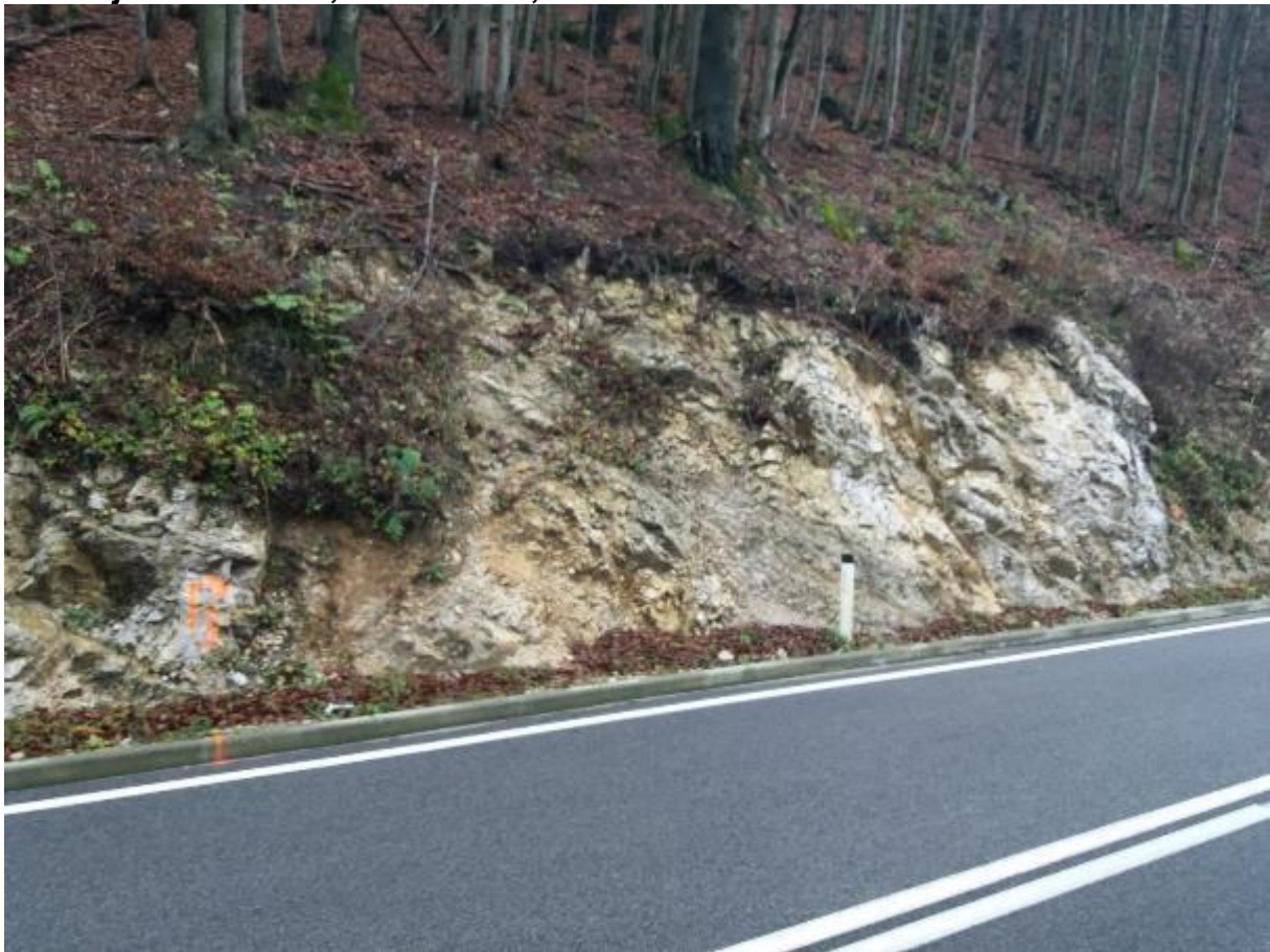
Lokacija 3 od km 4,070 do km 4,085
