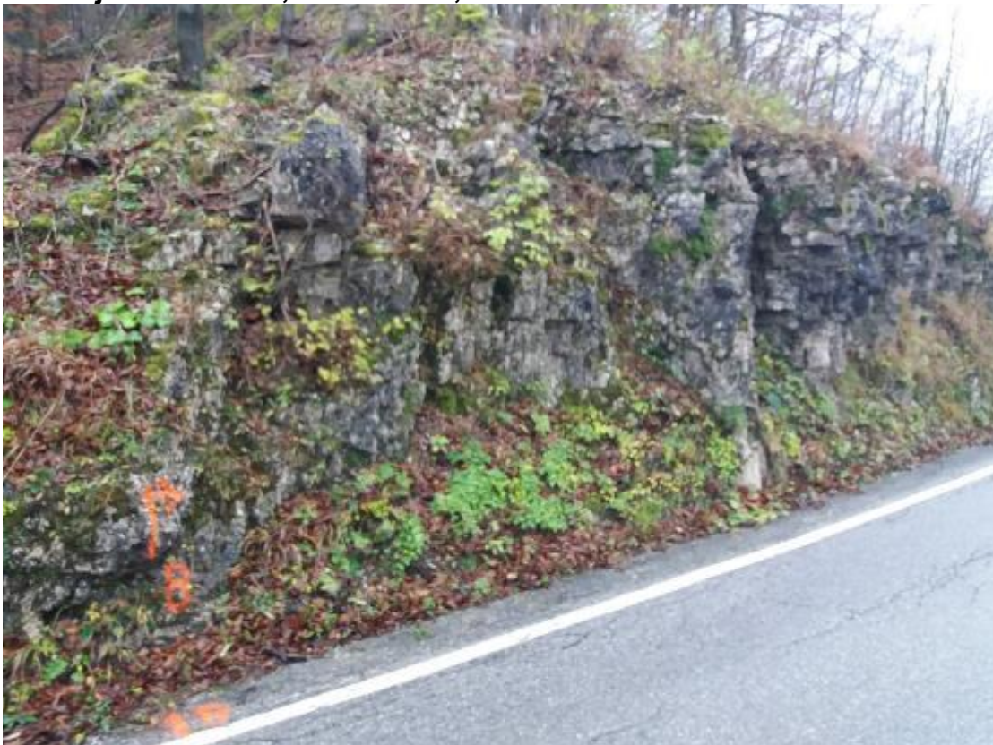
Lokacija 8 od km 4,720 do km 4,845
