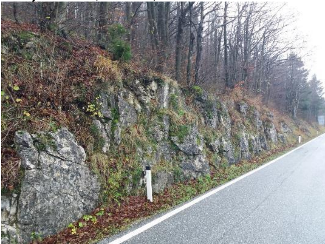
Lokacija 10 od km 5,077 do km 5,138
