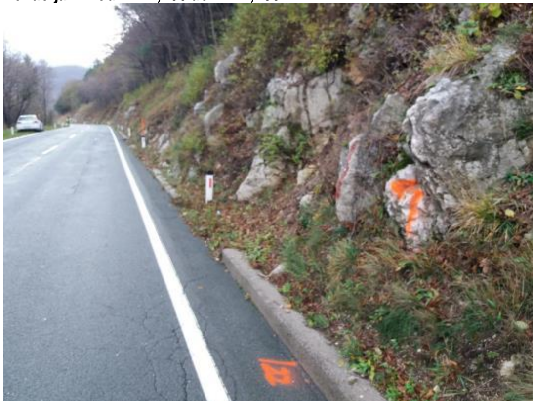
Lokacija 22 od km 7,100 do km 7,185
