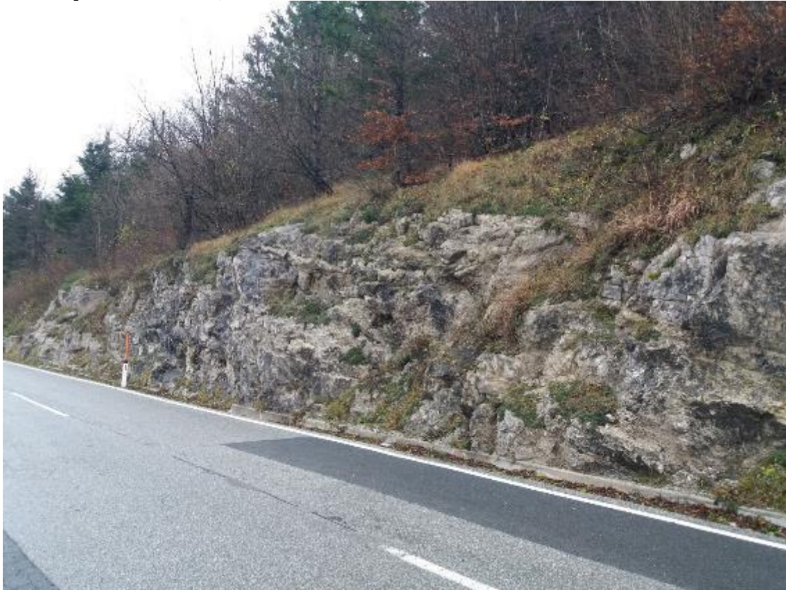
Lokacija 11 od km 5,260 do km 5,340
