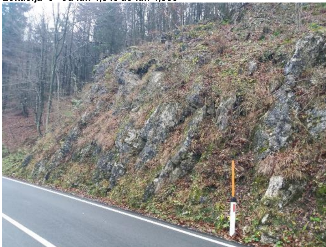
Lokacija 6 od km 4,545 do km 4,585
