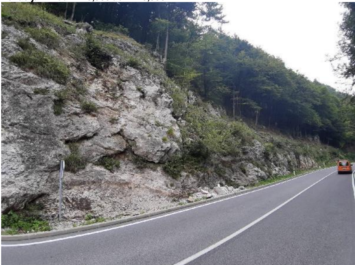
Lokacija 2 od km 3,900 do km 3,930
