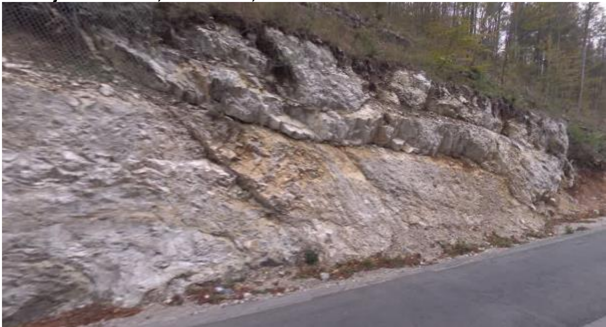
Lokacija 1 od km 3,557 do km 3,575
