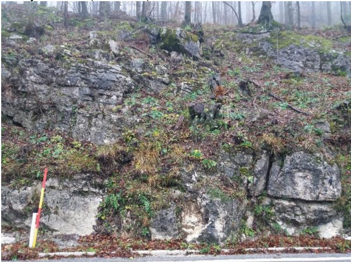
Lokacija 9 od km 4,985 do km 5,035
