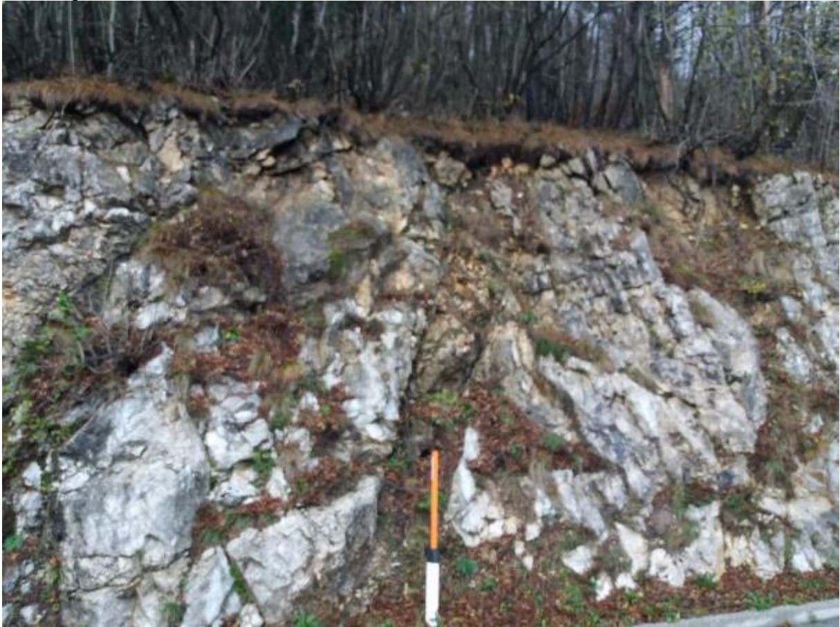
Lokacija 17 od km 6,286 do km 6,515
