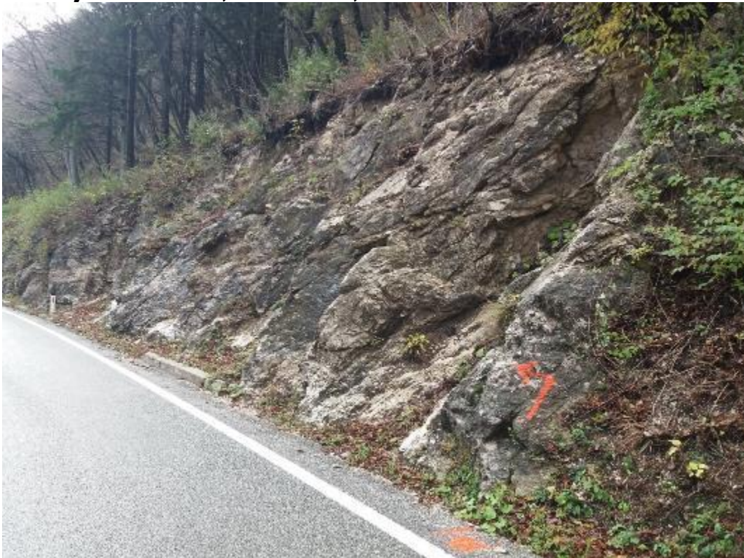
Lokacija 18 od km 6,605 do km 6,684
