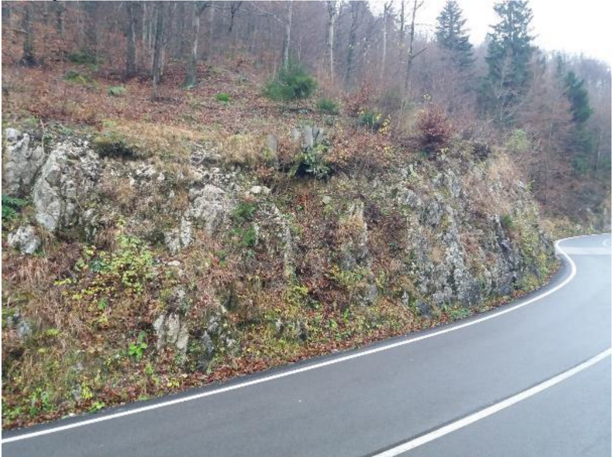
Lokacija 7 od km 4,600 do km 4,660
