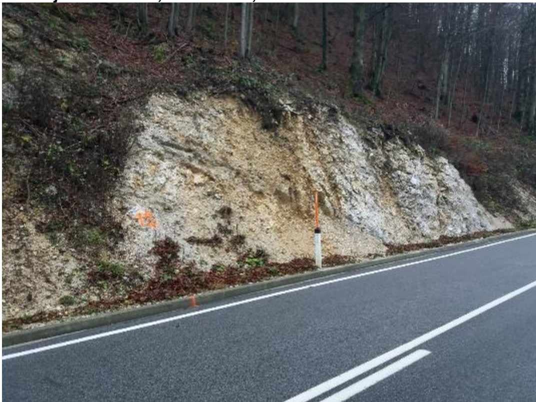
Lokacija 4 od km 4,090 do km 4,110
